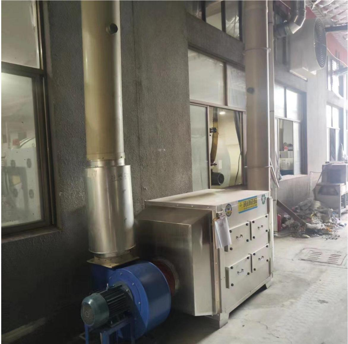
图 3-5 注塑废气处理设施现场图
