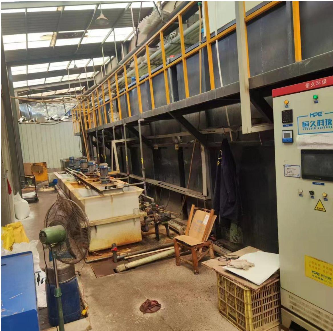
图 3-3 生产废水处理设施现场图
