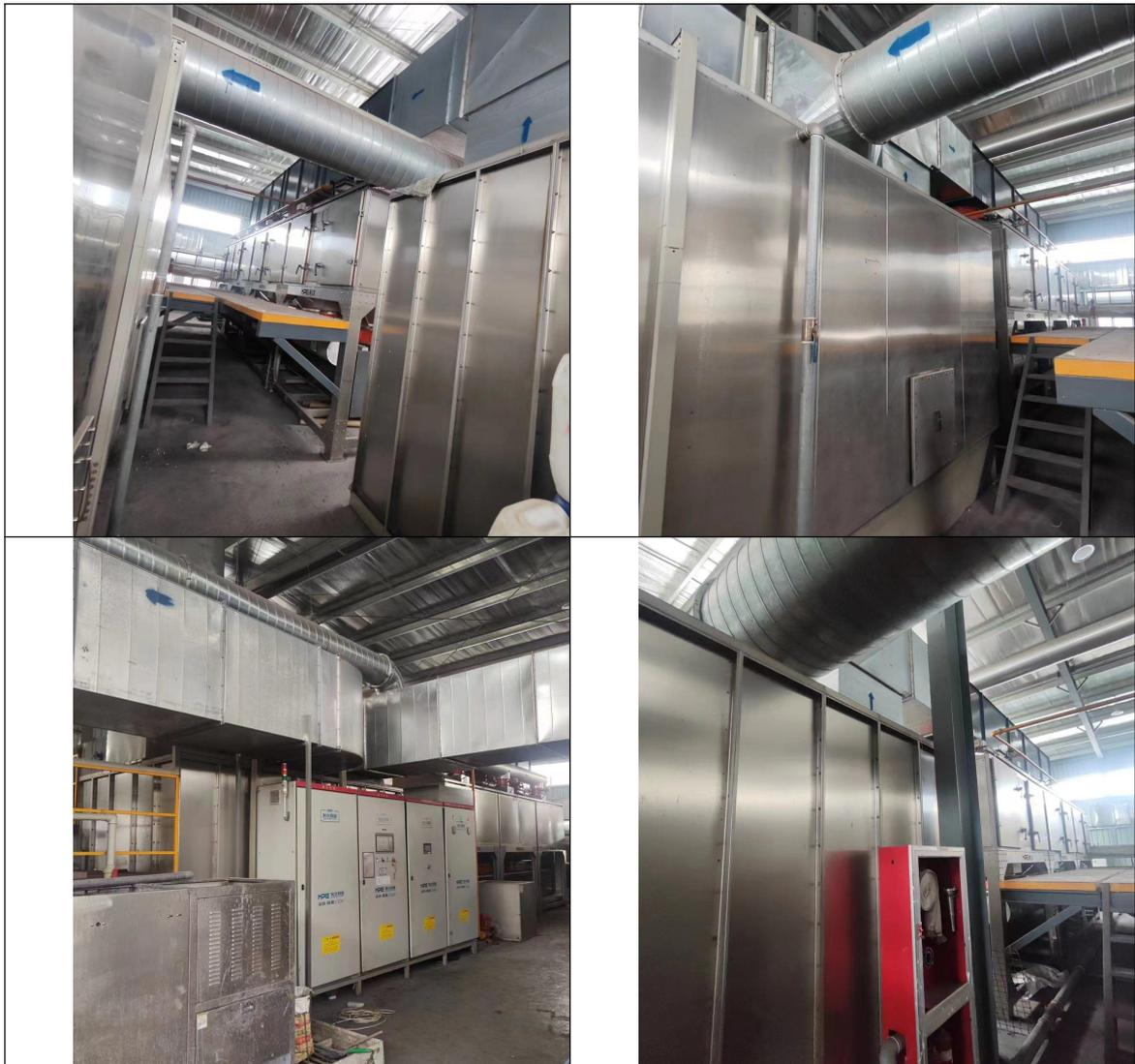
图 3-11 丝印、烘干、燃烧、喷漆废气处理设施现场图
