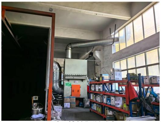
图 3-6 喷塑废气处理设施现场图
