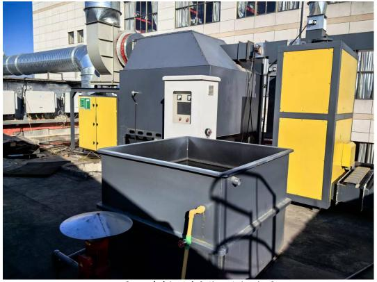
图 3-9 喷漆烘干废气处理设施现场图
